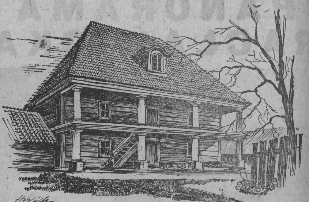
Na Podlasiu w minionych wiekach wykształcił się w budownictwie ludowym indywidualny styl architektoniczny, wyróżniający się wśród stylów innych regionów solidnością konstrukcji, prostotą, praktycznymi rozwiązaniami i doskonałymi proporcjami bryły budowli.
