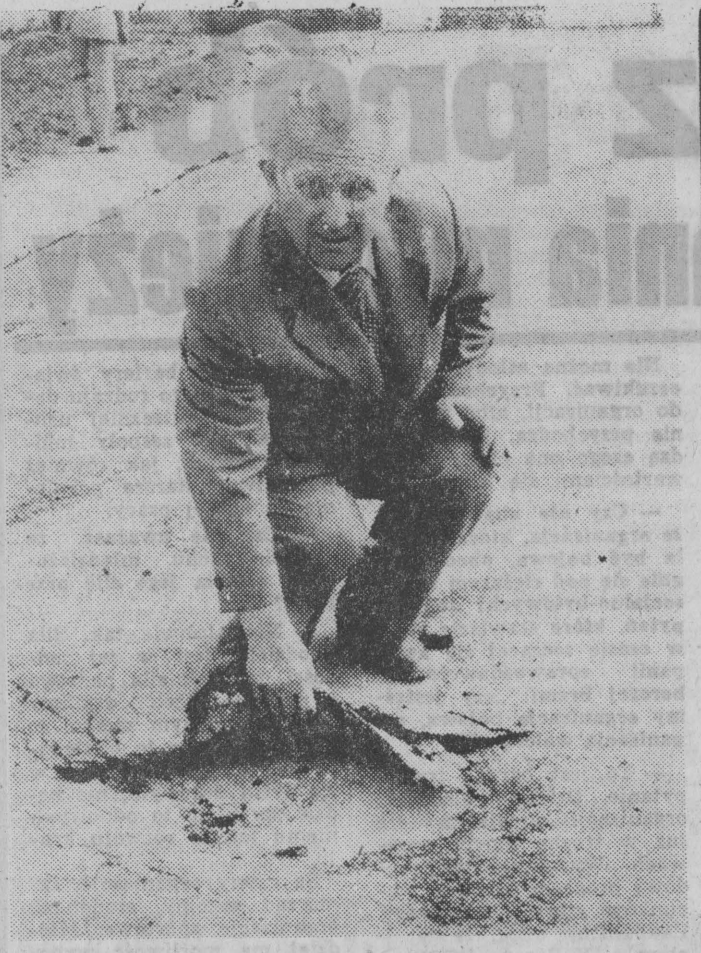
Dyrektor Ryszard Petas demonstruje walory nowej nawierzchni asfaltowej w sąsiedztwie stacji uzdatniania wody.
