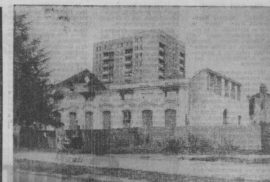
Po rewaloryzacji z dawnego obiektu pozostaje często jedynie zewnętrzna skorupa. Dom przy ul. Noniewiczza ma w przyszłości spełniać rolę centrum młodzieżowej kultury.
