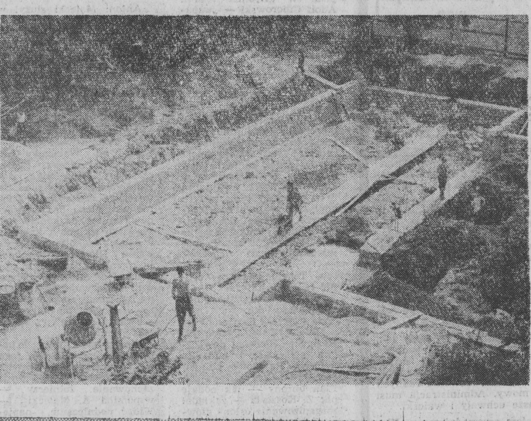
Z dachu widoczny już jest zarys powstającego aktualnie lewego skrzydła.
