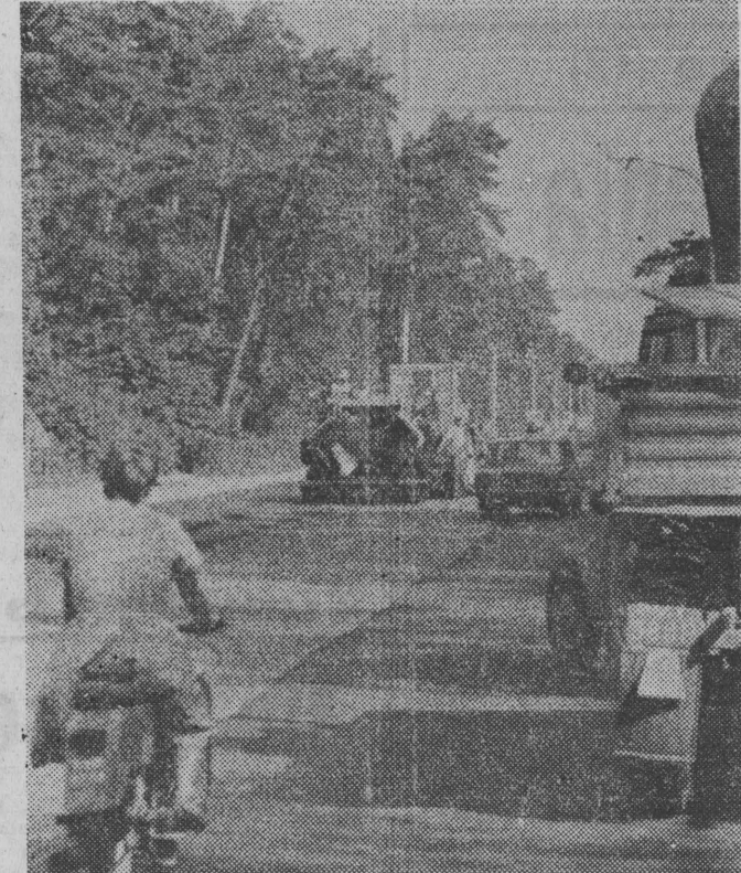
Wszystkie roboty ziemne i nawierzchniowe były wykonywane przy ruchu ciągłym pojazdów. Wykonawcom przy sparszało to wielu kłopotów, ale ograniczenia w ruchu — dzięki temu — były minimalne.
