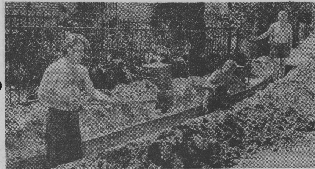
NA ZDJĘCIU: Wykopy gazociągowe wykonują sami mieszkańcy.
