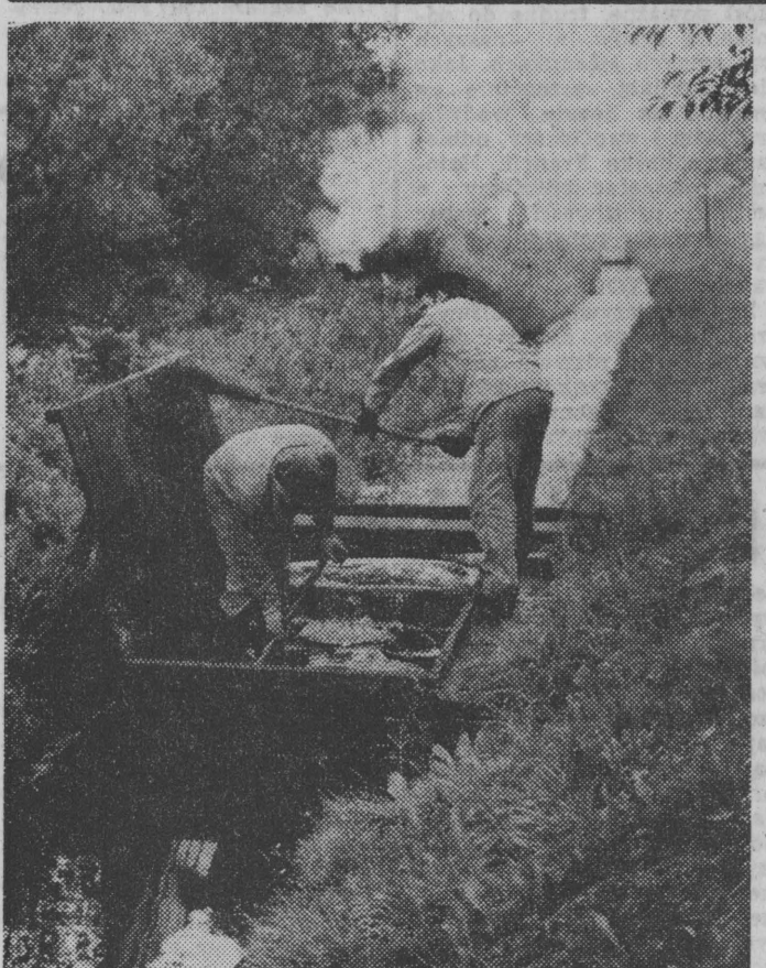
NA ZDJĘCIU: pracownicy Hajnowskiego Przedsiębiorstwa Suchoj Destylacji Drewna podczas oczyszczania filtrów. prymitywnej oczyszczalni wstępnej.
