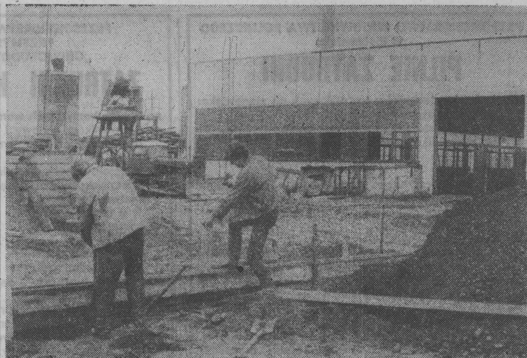
W kończącej fazę wkręcenia prace przy budowie suwalskiego Polmozytu. Fot. R. ŁYSIONEK
