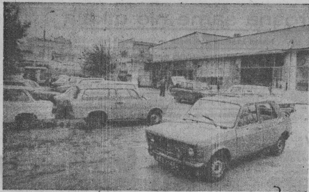
Choć trwają jeszcze roboty wykończeniowe, na nowych stanowiskach przyjmowane są już samochody. Widoczny na zdjęciu parking będzie powiększony — z drugiej strony hali — co zapewni lepszy i wygodniejszy dojazd.
