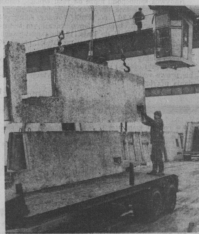
Niebaum gotowe elementy trafiają na plac budowy. FOT. Z. LENKIEWICZ
