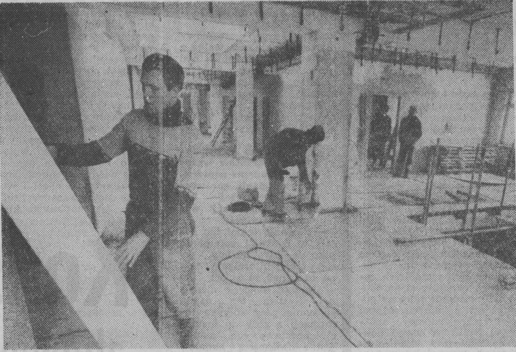
Meldunek z budowy Centrum Onkologii na warszawskim Ursynowie.
