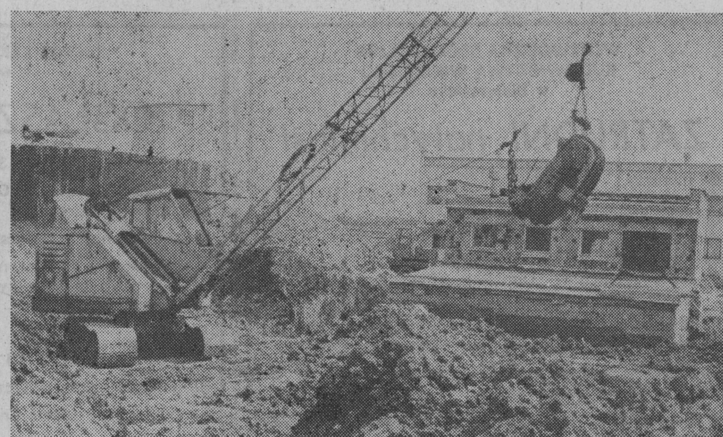
GIZYCKO. Na budowie Stacji Udatniania Wody trwają końcowe roboty ziemne, a także prace montażowe urządzeń i instalacji. O przebiegu i zakończeniu na tej budowie poinformujemy szerzej w najbliższych dniach.
