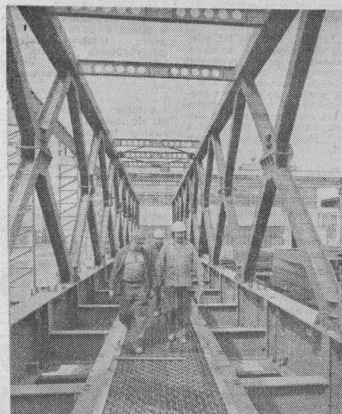
Ten kolejny most przeznaczony jest dla kolei. Załoga ZKKSUD. zbudowała ich już setki.
