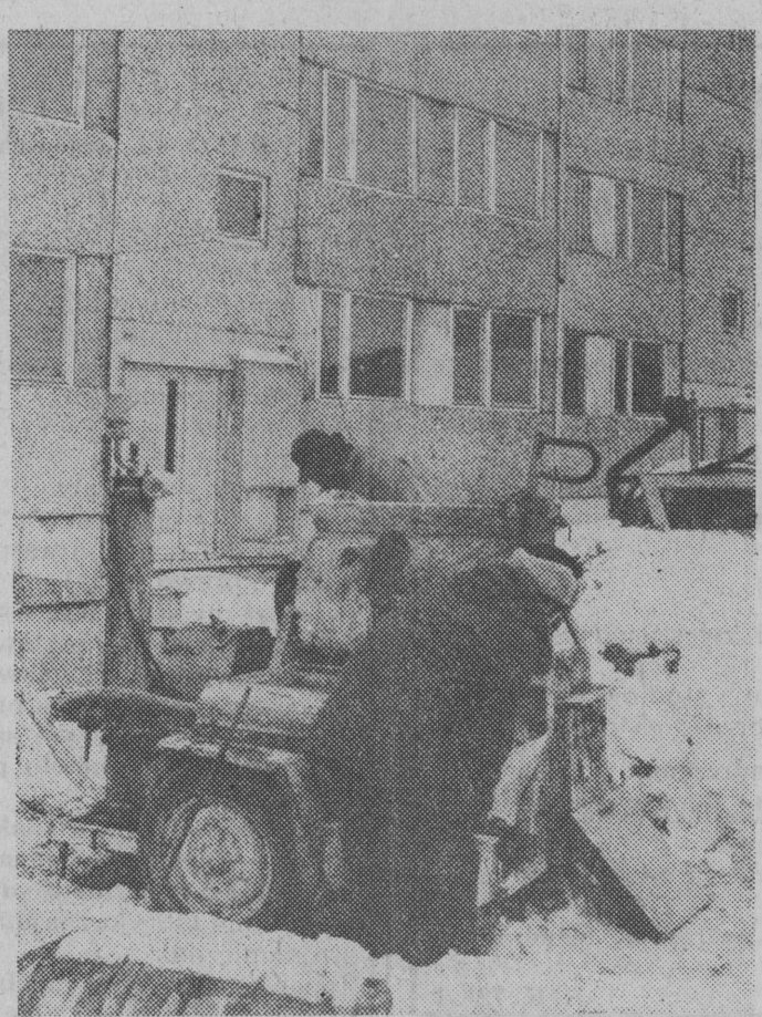
Spółdzielnia Mieszkaniowa w Szczuczynie buduje obecnie dwa bloki mieszkalne. W jednym z nich, posiadającym trzy piętra, mieszkać będą pracownicy i rodziny. Drugi jest w montażu. Wykonawcą prac budowlano-montażowych jest Przedsiębiorstwo Budownictwa Rolniczego w Grajewie.
