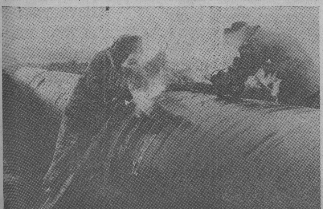
Układanie gazociągu na odcinku od granicy obwodu tambońskiego do lewego brzegu Donu. Pracująca na tym odcinku brygada ukończyła, z okazji 40-lecia Kraju Rad 42-kilometrowy odcinek w czasie krótszym o trzy miesiące od przewidywanego. NA ZDJĘCIU: spawanie rur.
