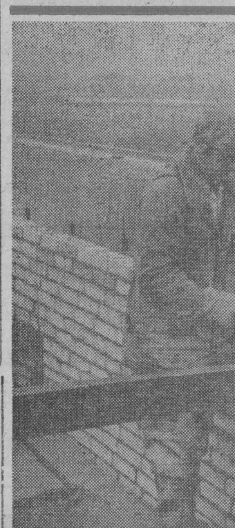
To już ostatnia kondygnacja kolejnego budynku na „Centrum II”. STANISŁAW ZUKOWSKI z Biłostockiego Kombinatu Budowlanego od rana pracownicy machą kielnią.
