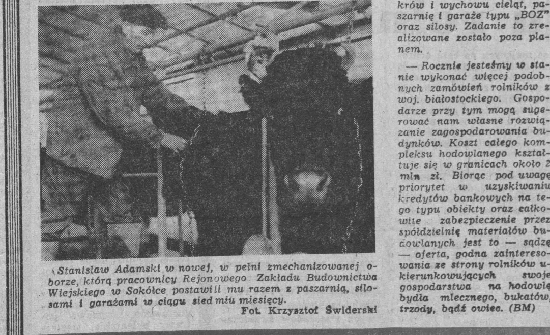
Stanisław Adamski w nowej, w pełni zmechanizowanej oborze, którą pracownicy Rejonowego Zakładu Budownictwa Wiejskiego w Sokółce postawili mu razem z paszarnią, stłosami i garażami w ciągu siedmiu miesięcy. Fot. Krzysztof Świdarski
