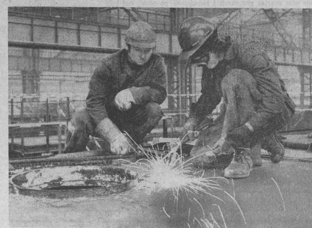
Grupowy ślusarz Ryszard Dotkowski i spawacz Kazimierz Narewski przy naprawie dachu wagonu.
