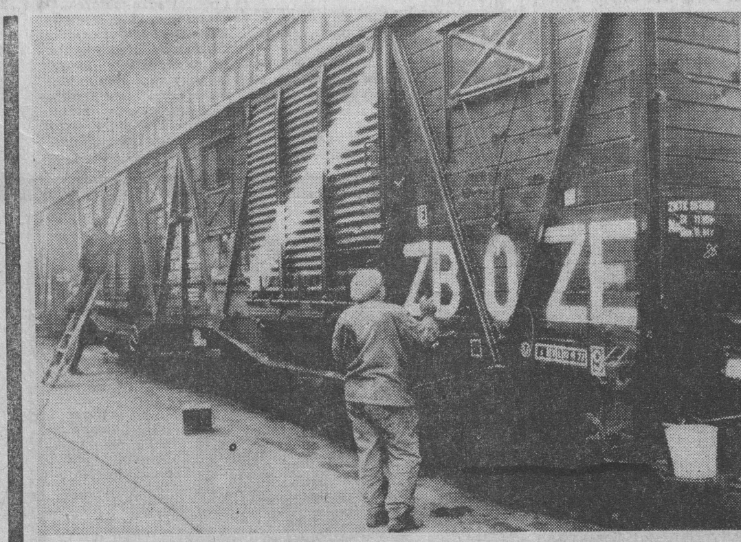
Końcowy fragment linii napraw wagonów towarowych.
