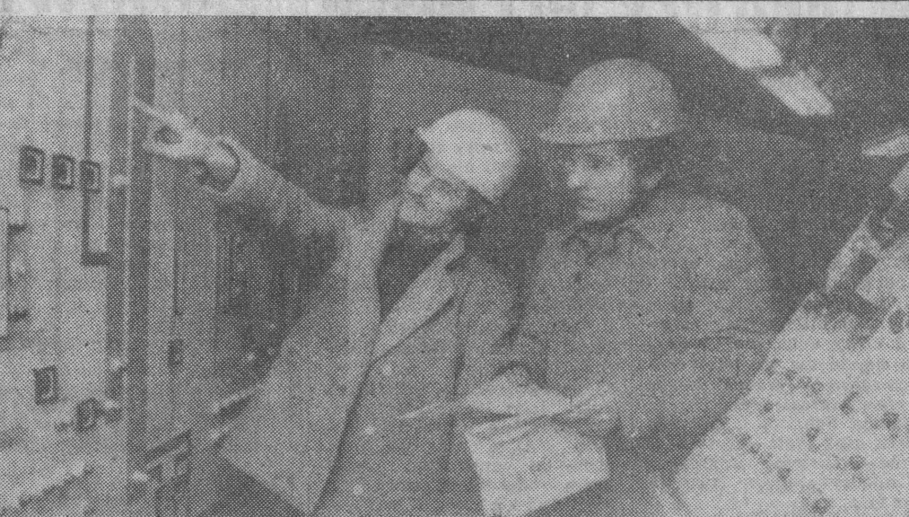
HUTA KATOWICE. Do uruchomienia drugiego wielkiego pieca w Hucie Katowice pozostało niewiele czasu. Zanim ruszy automatyka drugiego pieca, należy wykonać ogromną i odpowiedzialną pracę — zainstalować i sprawdzić tysiące połączeń, zapewnić precyzyjne działania skomplikowanych urządzeń. NA ZDJĘCIU: przybyli użytkownicy pomiarowi — Henryk Ostach i Krzysztof Zdrański pomagają przy pracach, zapoznając się równocześnie z działaniem urządzeń automatyzacji wielkiego pieca. CAF-Seko-telefoto
