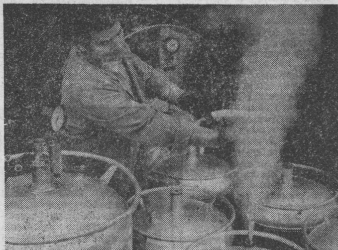
Próby kriostatów i zbiorników na ciekłe gazy wykonuje Zenon Kaczor.
