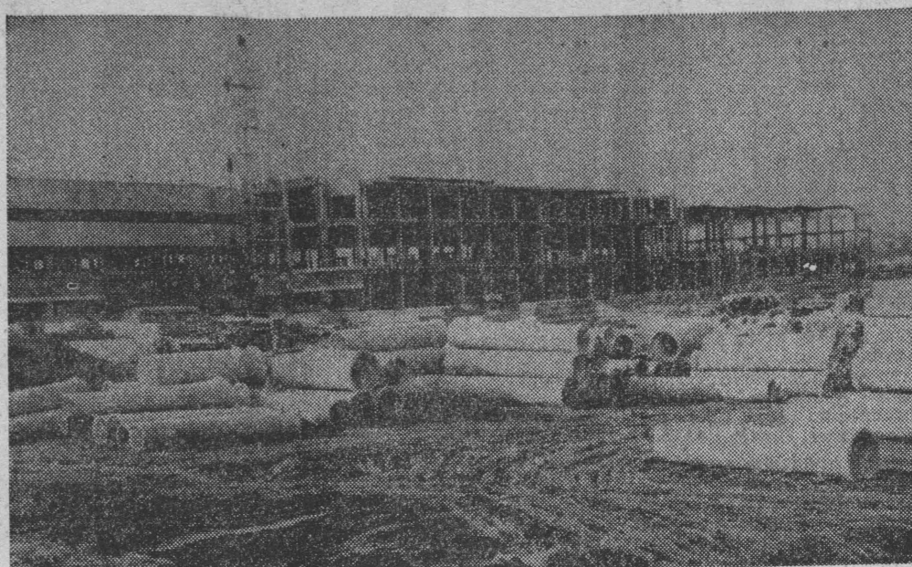
W tym roku sporo pozostało do zrobienia. Całą tkalnię trzeba „zamknąć”, to znaczy zmontować ścianki osłonowe.
