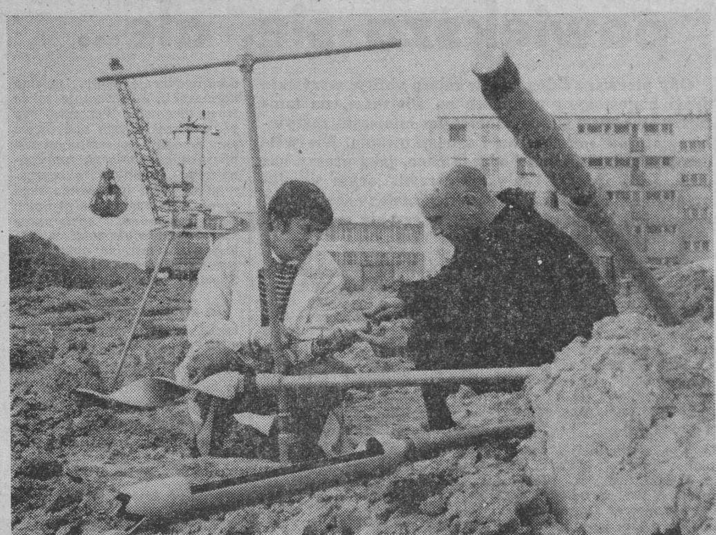
NA ZDJĘCIU: dr inż. Jacek Stróżecki — konstruktor zestawu urządzeń do geotechnicznych badań polowych i technik — Jan Ziemiński (w białym fartuchu) pobierają próbkę gruntu na placu budowy.
