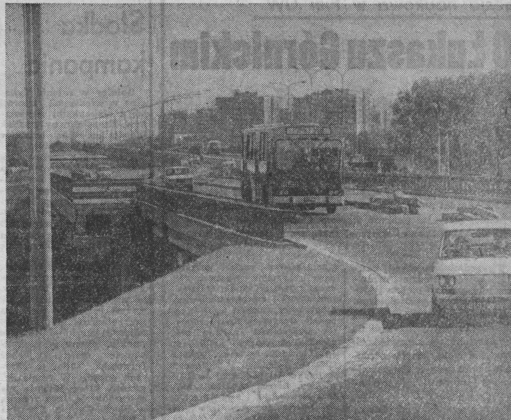
Prace przy budowie kolejnej, stolecznej inwestycji komunikacyjnej — Trasy Toruńskiej, prowadzone są na wielu odcinkach. Będzie to nowoczesna arteria przeznaczona dla ruchu miejskiego i tranzytowego. Węzeł drogowy nad ulicą Modlińską mieć będzie cztery poziomy. NA ZDJĘCIU: ruch na ślimaku zjazdowym z Trasy Toruńskiej na ulicę Modlińską. CAF — Dąbrowiecki
