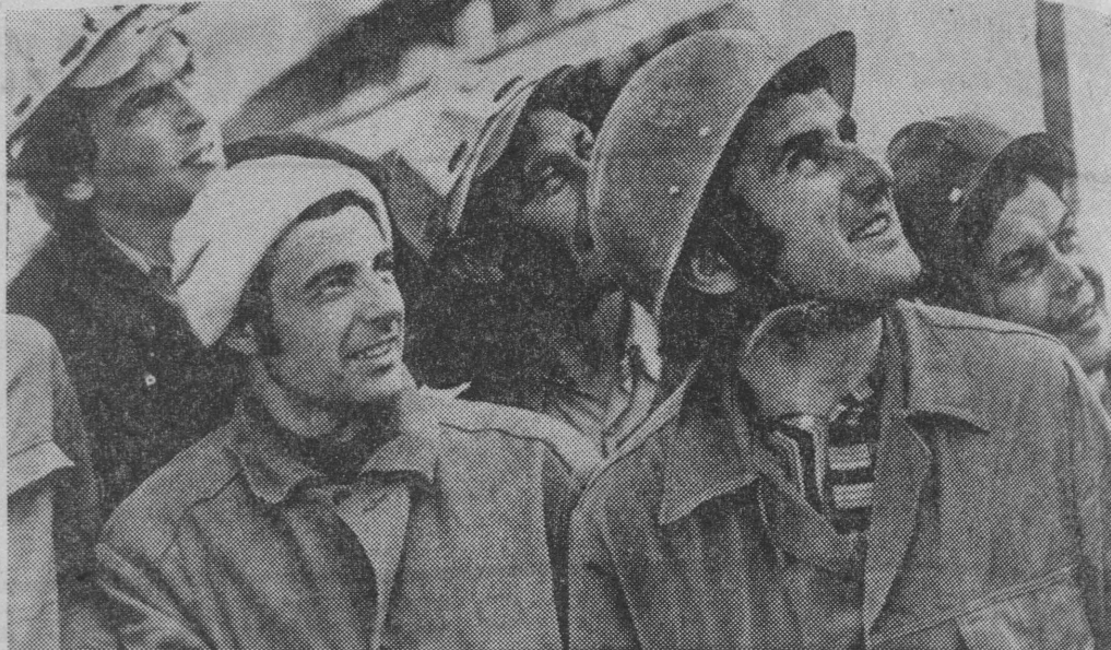
ZSRR. Dla uczczenia 60 rocznicy Rewolucji Październikowej załoga budująca „Atommasz”, za- kłady budowy urządzeń dla elektrowni atomowych powstających w Wołgodońsku, zobowiązała się zakończyć pierwszy etap prac przy głównej hali kombinatu. NA ZDJĘCIU: produkująca brigada budowlanych. CAF-TASS
