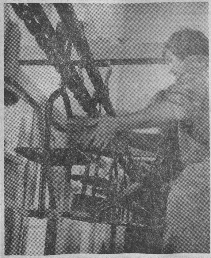
Walenty Zajkowski nakłada cegły na transporter. Fot. K. Świdorski
