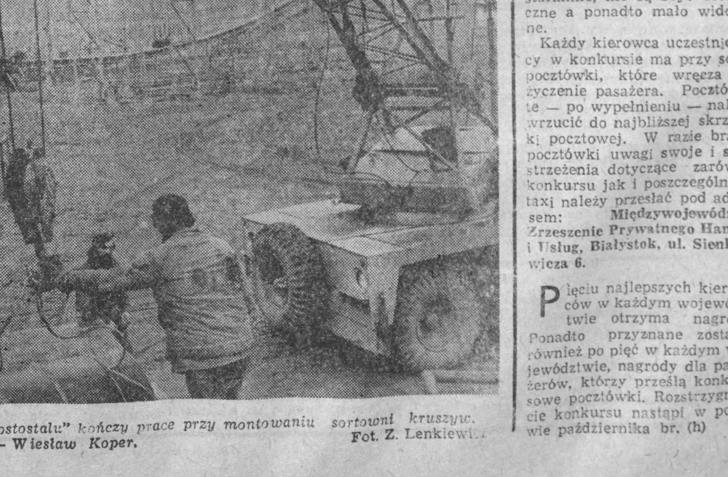
Brigada pióckiego „Mostostalu” kończy prace przy montowaniu sortowni kruszywa. W środku — brigadzysta — Wiesław Koper. Fot. Z. Lenkiewicz
