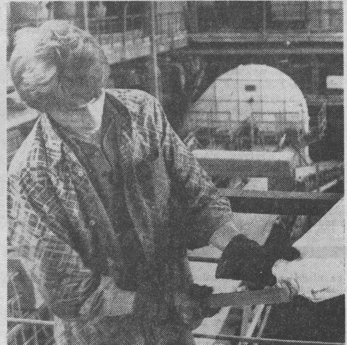
Slusarz Zygmunt Tymński przygotowuje do montażu elementy filtracyjne.
