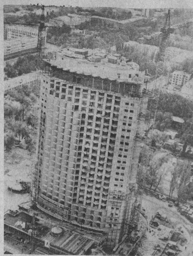
Alma-Ata. Budowa nowego hotelu o specjalnej, antysejsmicznej konstrukcji, przewidzianej na tysiąc miejsc.
