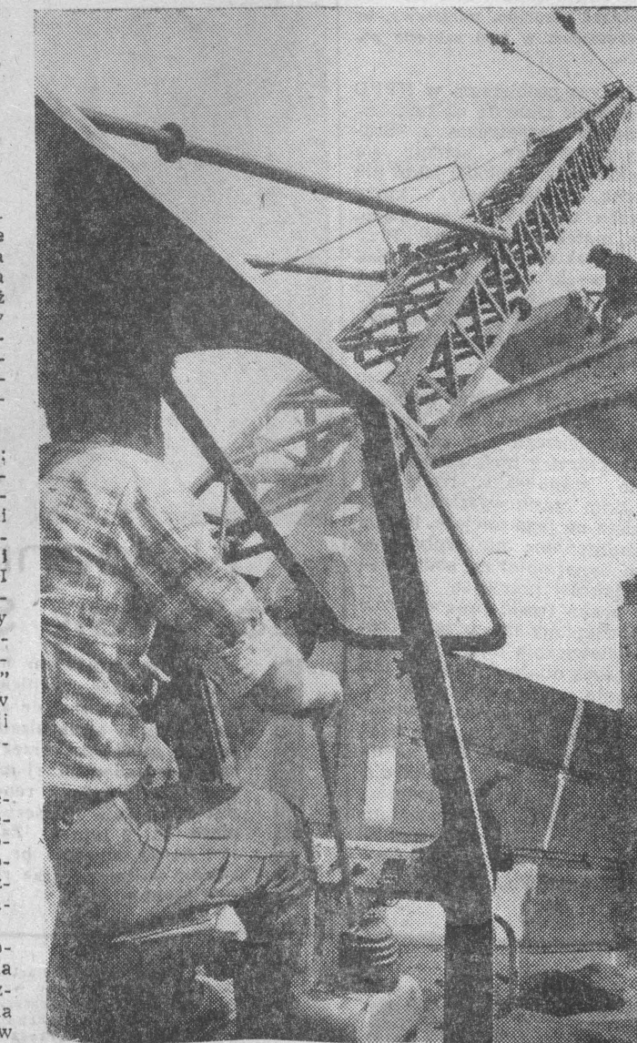
Pod kierownictwem brygadzysty Mirosława Zakraszewskiego dobiega koniec montażu magazynu lakieru.
