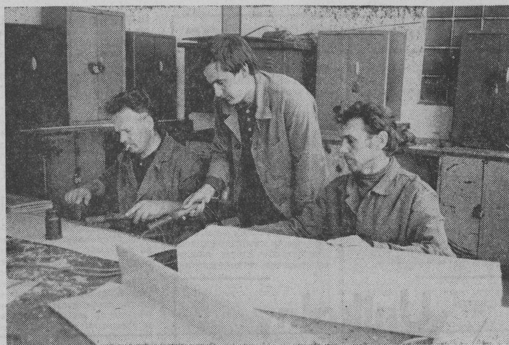
Przy wykonywaniu urządzeń instalacyjnych dla budowanego gmachu Urzędu Wojewódzkiego w Łomży, pracują członkowie produkcyjnej brygady Ludwika Jackowski (pierwszy z lewej) Marek Świercz 1 Aleksander Borawski.
