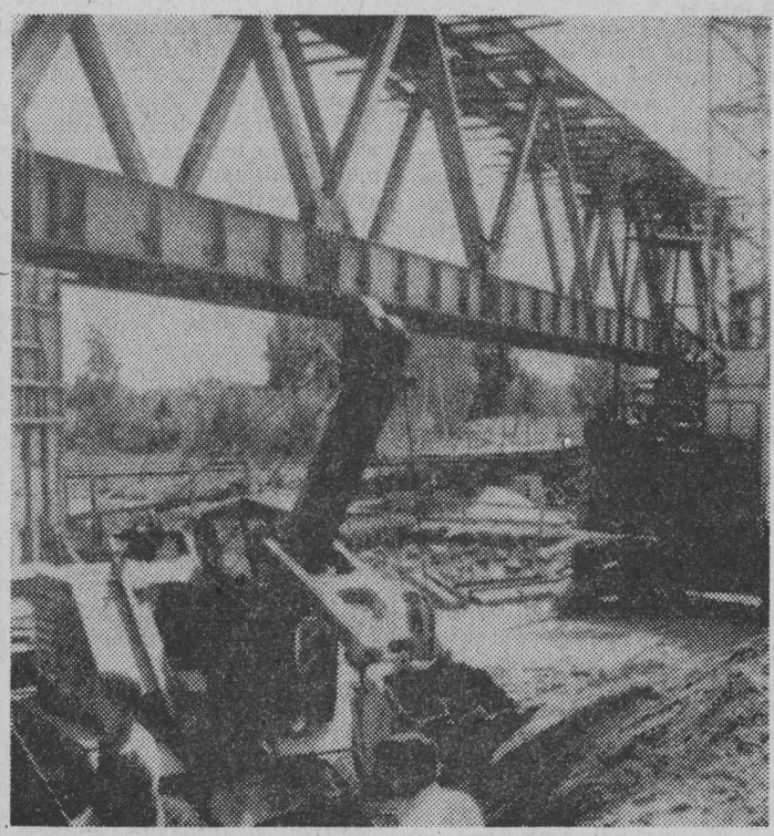
Na budowie Centralnej Magistrali Kolejowej roboty koncentrują się obecnie na odcinku Mazconów—Grodzisk. Oprócz prac ziemnych wznosi się tu wiadukty i tzw. przepusty. Największy most znajduje się nad torami kolejowymi Warszawa — Skierniewice, w miejscowości Jaktorów. Zakończenie tego odcinka przewidziane jest na koniec roku.
