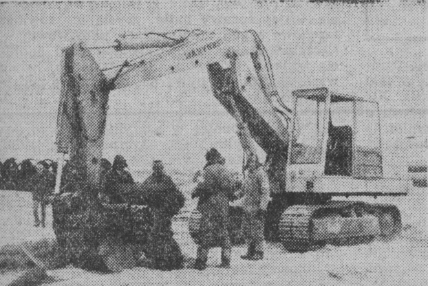
W budowie rurociągu orenburskiego świetnie spisują się ekipy pracowników z Polski. Dobrze także zdaje egzamin nasz sprzęt specjalistyczny m. in. z zakładów im. Waryńskiego.
