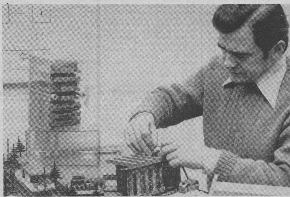
NA ZDJĘCIU: mgr inż. Bolesław Świdzki z COBIRTK przy modelowym urządzeniu samoczynnej blokady liniowej. CAF — Dąbrowiecki
