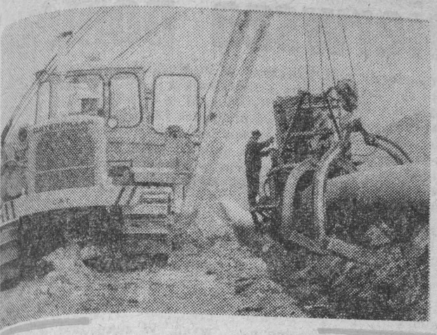
ZSRR. Izolowanie i układanie gotowego rurociągu przy pomocy specjalnego zestawu maszyn na budowie rurociągu Północnego. Ekipy ENERGOPOLU przekroczyły plan ubiegłego roku; ułożono 177 km rur, a zespawano 286 km.
