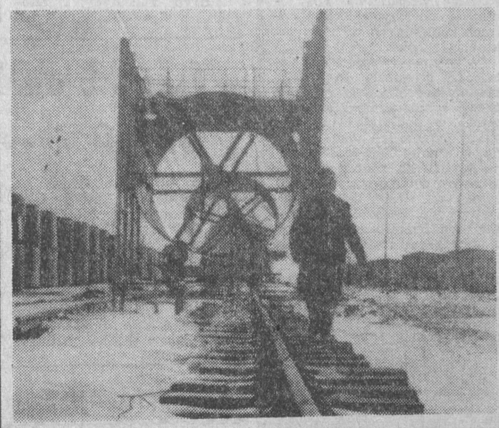
Na budowie cementowni WIERZBICA II w woj. radomskim, roboty koncentrują się przy realizacji młynów surowca i zbiorników korekcyjnych...
