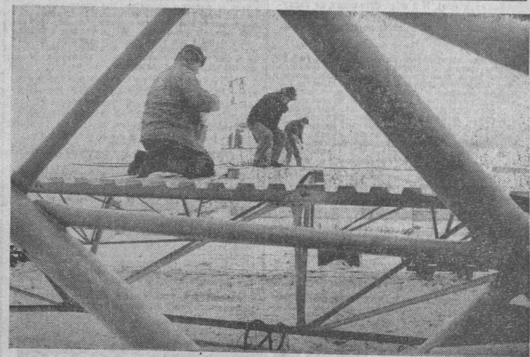
Dachem zostanie przykrytych 5 hektarów.
