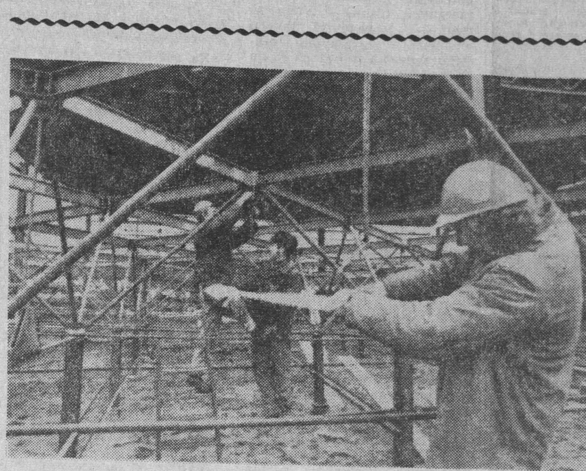
Zwiększa się obszar Międzynarodowych Targów Poznańskich. Niektórzy wystawcy krajowi, a także zagraniczni otrzymują nowoczesne hale, niektóre będą gotowe już na tegoroczne MTP. NA ZDJĘCIU: montaż konstrukcji dachowej hali dla wystawy angielskiej. CAF — Starzyński — telefoto
