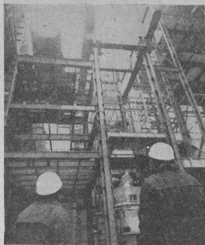
W elektrowni „Rybnik” zakończono modernizację kotłów 2 bloków. Jednocześnie trwa rozbudowa, w ramach której powstanie dalsze 4 bloki o mocy 200 MW każdy.
