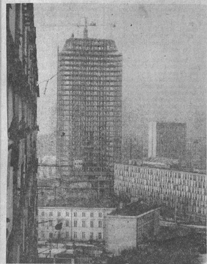
Warszawa — gmach Polimeksu - Cokpu w budowie. CAF — Rosiak
