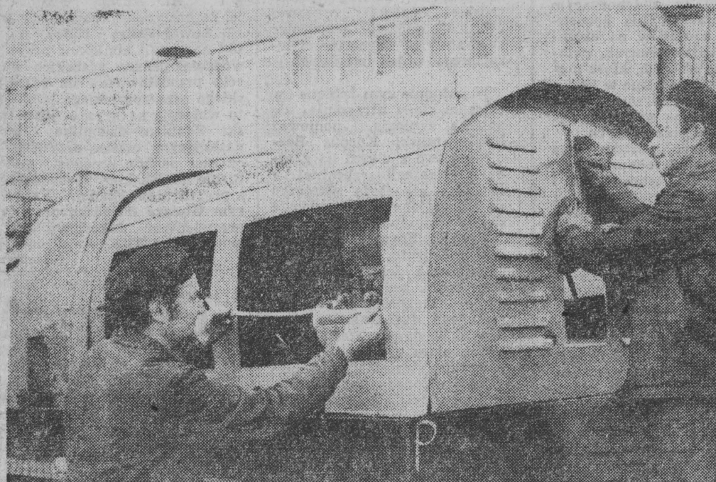
Ostatnie prace przy budowie kotła. Wykonują je Jerzy Bęczek i Zenon Rybnik.
