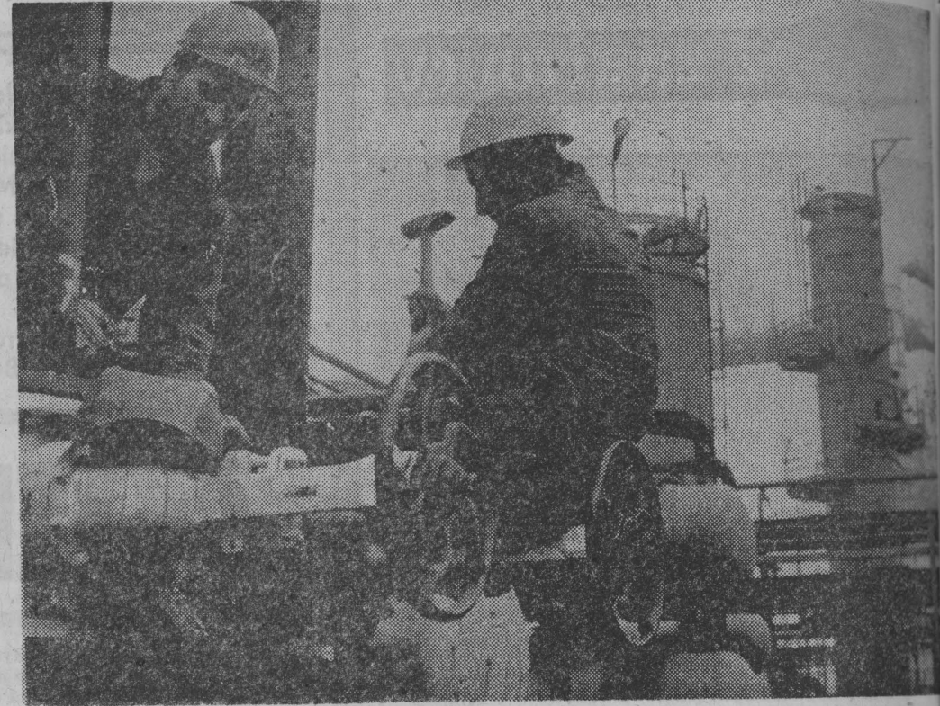
NA ZDJĘCIU: na budowie bloku olejowego pracą kieruje mgr inż. Andrzej Chab roweński
