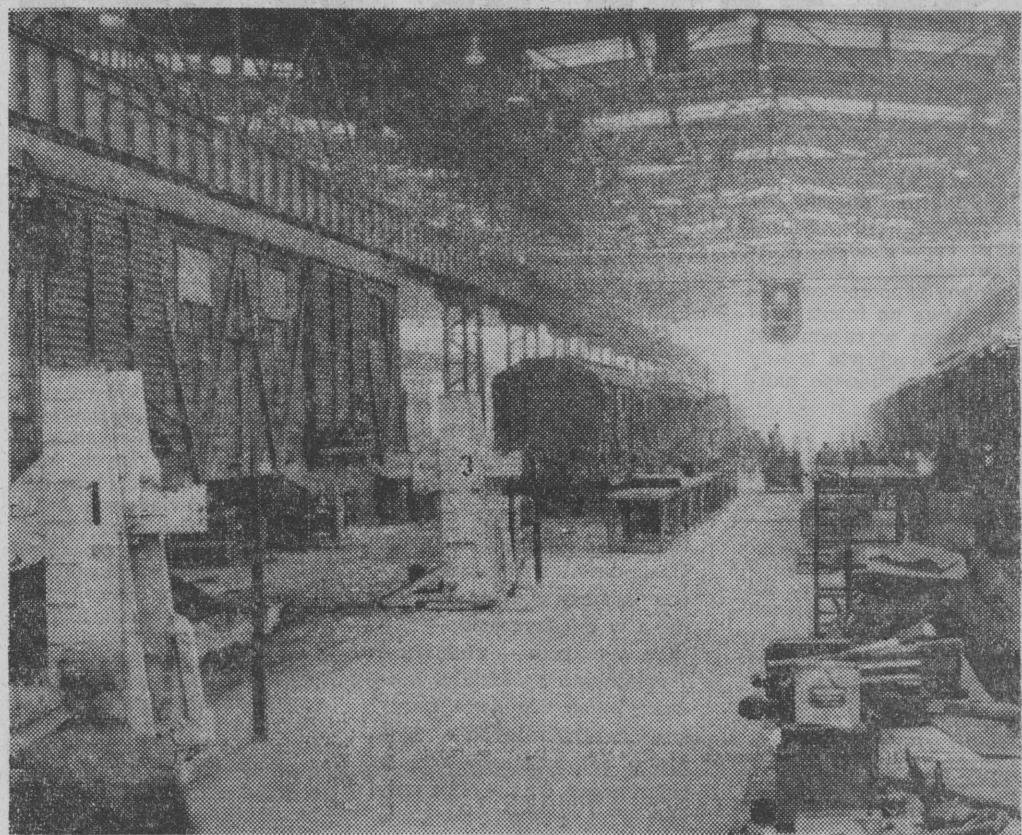
Fragment nowej hali napraw głównych wagonów 4-osowych.
