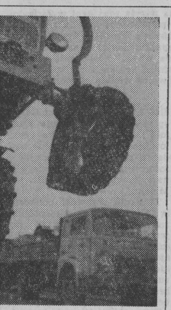
Dziesięć miesięcy roku „Ursus” zamknął przekroczeniem planu o 60 maszyn — wyprodukowano tu w tym czasie 48.335 cięgniów i o 20 proc. więcej, niż przewidywano — części zamienne. Jedenaście tysięcy pracowników zakładu biorze udział w ogólnokrajowym konkursie DO-RO.
