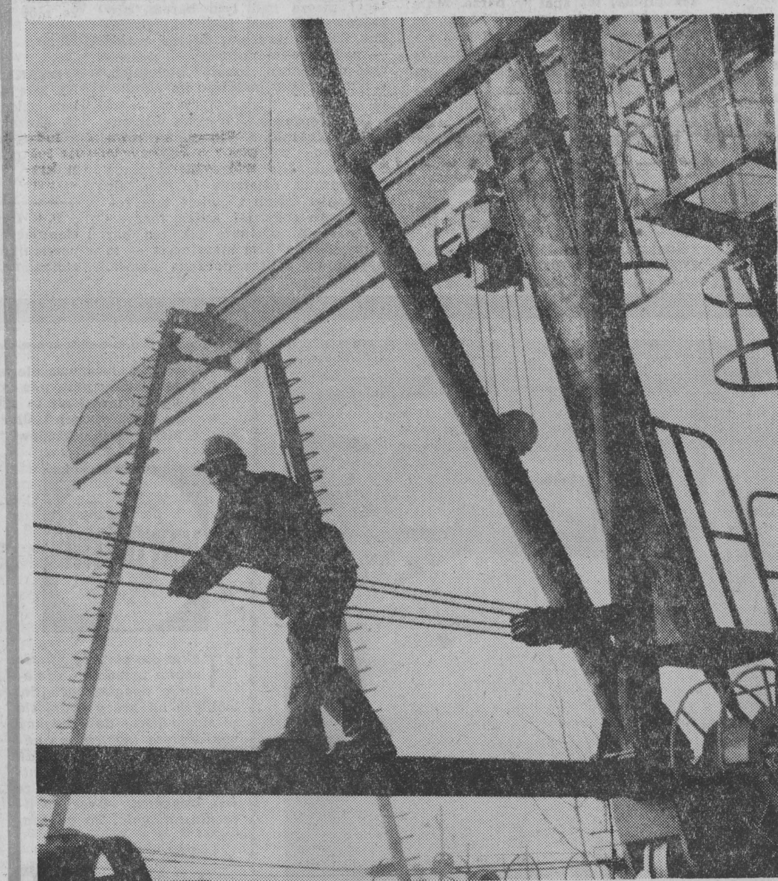
NA ZDJĘCIU: Ireneusz Komoń pracuje przy montażu suwnicy bramowej.
