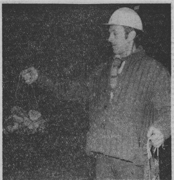
Jeden z pracowników, Zygmunta Dąbrowskiego, prezentuje kamienie wydobycie z rur doprowadzających ciepłą wodę do mieszkań osiedla „Centrum II”.
