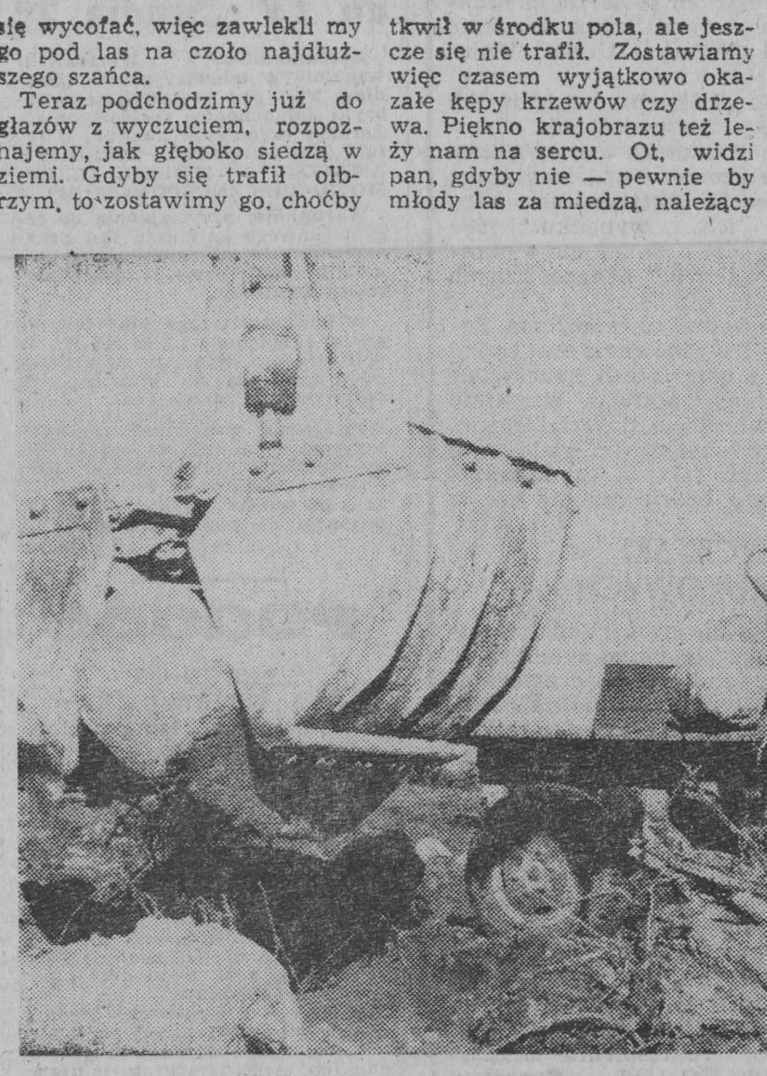
Najważniejsze i najszybciej realizowane obecnie zadanie w Belchatowskim Zagłębiu Węglowym to montaż wielkiej koparki kolowo-czerpakowej. Przygotowano już dwa podstawowe jej zespoły: wysięgnik przeciwwagi i wysięgnik koła czerpakowego oraz połowę mostu załadunkowego. Spod 7 tys. ton zamontowano obecnie około 4 tys. ton. W połowie przyszłego roku cały gigant zostanie przetransportowany na teren pierwszych wykopów. NA ZDJĘCIU: montaż belchatowskiego kolosa. CAF—Zbrannecki
