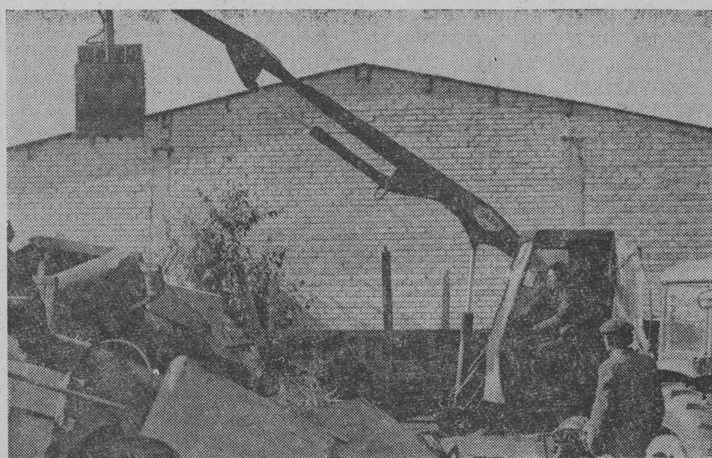
Załadunek złomu na wagony. Operator ładowarki — Tadeusz Walewski pracował w ostatnią wolną sobotę.
