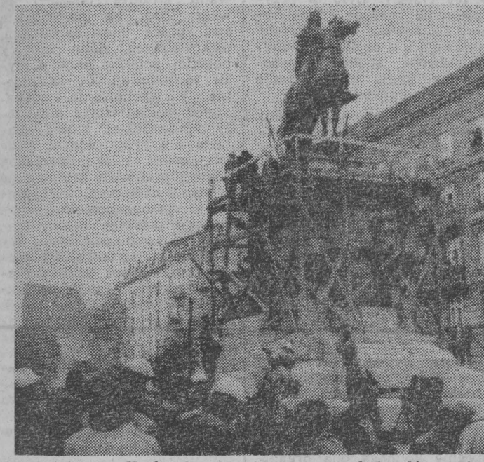
1 bm. w Krakowie zamontowano na cokole główną figurę Pomnika Grunwaldzkiego — postać króla Jagiełły na koniu. Wykonana przy pomocy śmigłowca operacja montażu wykonali pracownicy nazielskiego „Instytutu” pod kierownictwem Ignacego Golińskiego. NA ZDJĘCIU: montaż figury króla Jagiełły na koniu na cokole pomnika. CAF
