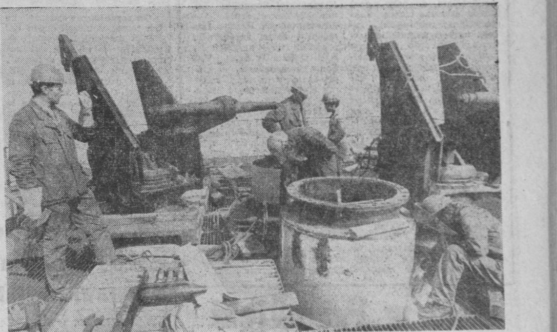
NA ZDJĘCIU: brygada Edwarda Jelonskiego z krakowskiego „Mostostalu” dokonuje operacji montażu urządzeń do wydmuchu na szczycie wielkiego pieca.
