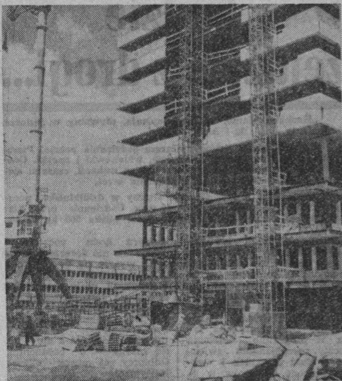
Wyraźnie zaznaczają się już obecnie szarys Centrum Zdrowia Dziecka, wznieszonego w Międzyzdrojach pod Warszawą. Równocześnie trwają prace montażowe i budowlane przy wszystkich budynkach całego kompleksu. Prowadzi się także roboty przy budowie podjazdów i parkingów. Wszystkie prace prowadzone są zgodnie z harmonogramem, budownictwo stara się, aby poszczególne odcinki robót kończyły według zaplanowanych terminów. Centrum Zdrowia Dziecka w Międzyzdrojach
