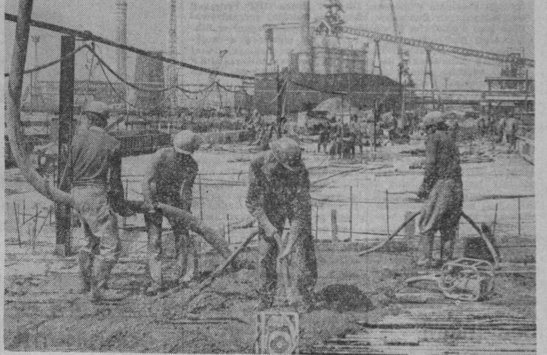
NA ZDJĘCIU: brygada kompleksowa Mariana Rojka z „Budostalu” betonuje estakadę surowki.
