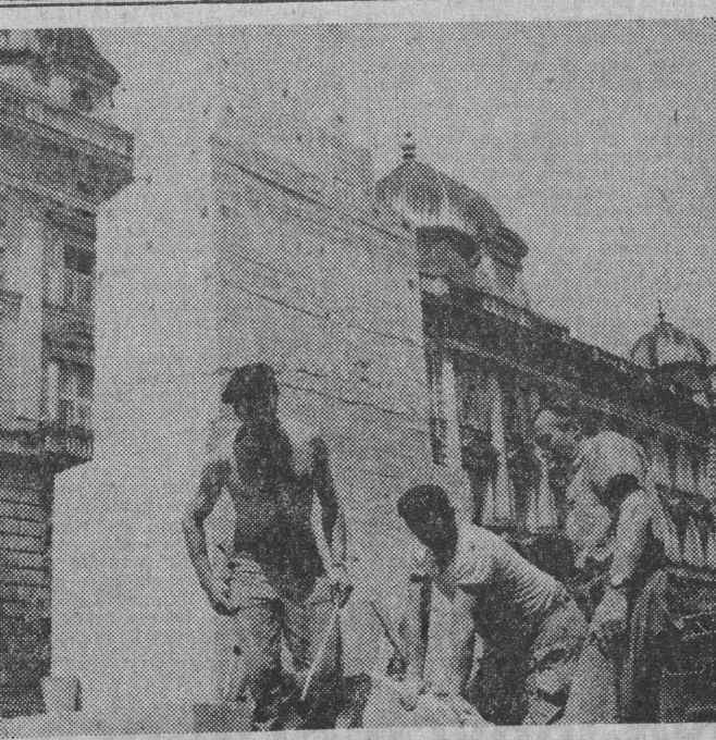
Odbudowa krakowskiego Pomnika Grunwaldzkiego wkraczała w ostatni etap. Na Placu Matejki rozpoczęto bowiem ułożenie cokołu. Będzie on jak cokoł pomnika zburzonego przez Niemców wykonany z granitu i złożony z 290 elementów.
