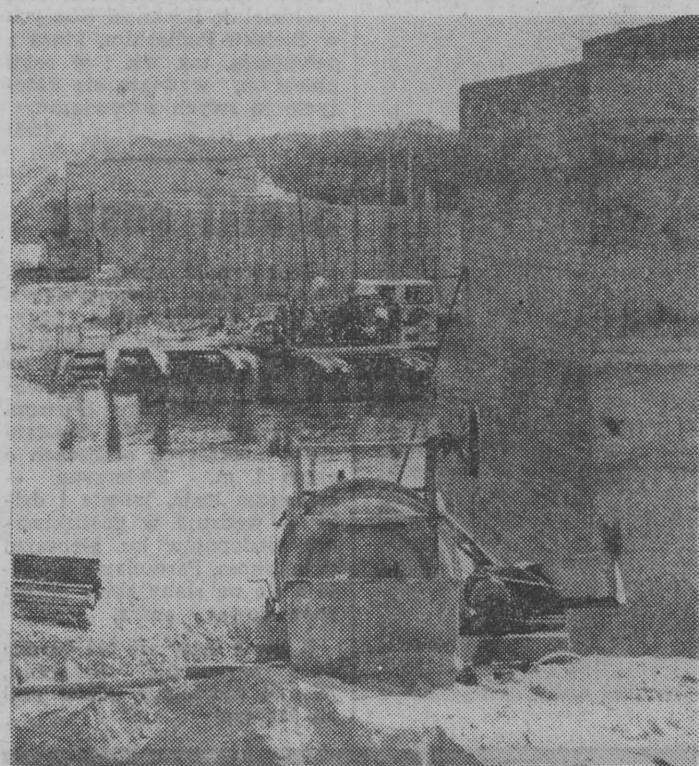
Budowa mostu na Pilicy.
