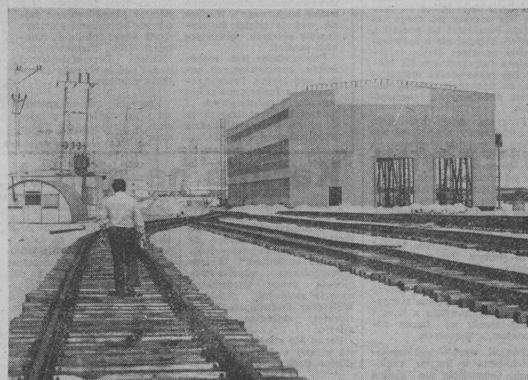
Budowa zaplecza technicznego.
